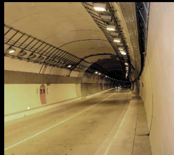
Автодорожный тоннель трассы Адлер – Красная Поляна
