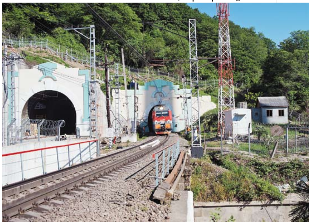
Тоннели №6 и №6 бис СКЖД
