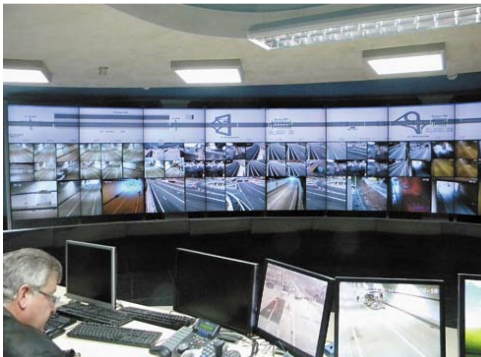
Диспетчерский центр управления автодорогой обхода г. Сочи
