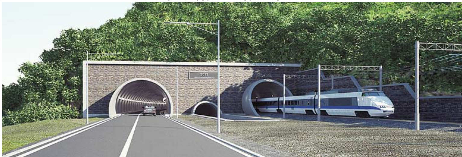
Совмещенный авто- и железнодорожный тоннельный комплекс трассы Адлер – горноклиматический курорт «Альпика-Сервис». Проект
