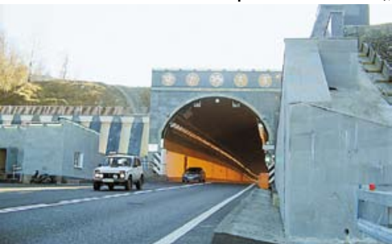
Автомобильный тоннель №3 на обходе г. Сочи, северный портал
