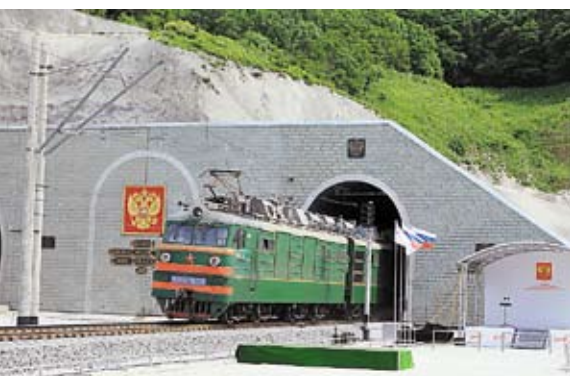
Большой Новороссийский тоннель СКЖД
